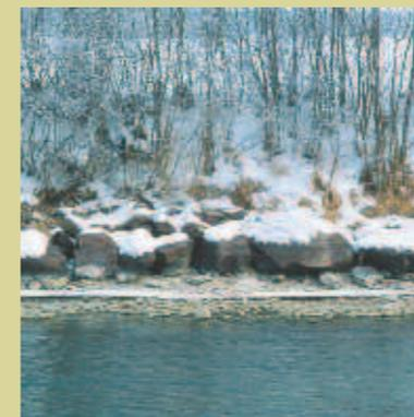
**Problem:** Durch starke Sohleintiefung hängen Uferverbauungen in der Luft und drohen einzustürzen. Gleichzeitig sinkt der Grundwasserspiegel. Ein Problem für die Au, die Landwirtschaft und die Hochwassersicherheit.
