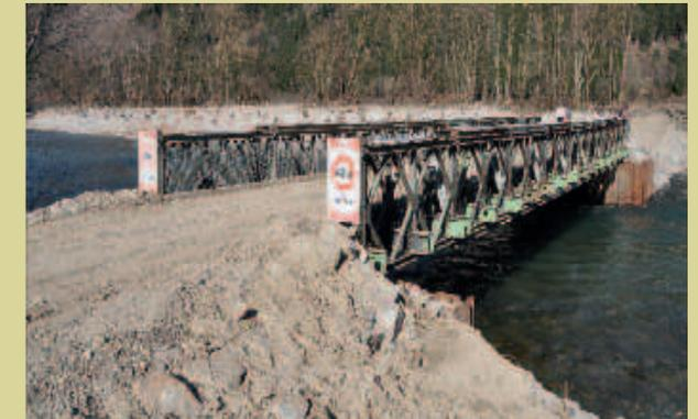
**Behelfsbrücke.** Um die Bauarbeiten auf der rechten Uferseite zu bewältigen, wurde zwischen Jänner und April 2011 eine provisorische Brücke über die Drau errichtet.
