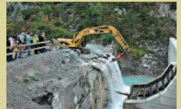
**Sperre öffne dich!** Nach der offiziellen Eröffnung wurde mit dem stufenweisen Abtrag der alten Sperre begonnen.
