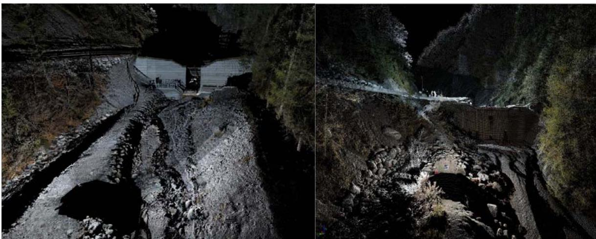
Abbildung 24: Punktwolken der neuen Sperre in der Laserscann-Aufnahme vom 16.11.2009 (links), im Vergleich dazu die alte Sperre 2008 (rechts)
