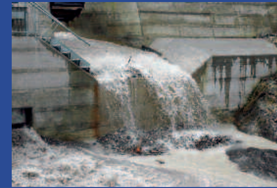
Neue Geschiebesperre am Berger Feistritzbach Sie verbessert den Hochwasserschutz für die Ortschaft Feistritz und gleichzeitig die ökologischen Verhältnisse am Unterlauf. Die Pflichtwassermenge kann gesteuert werden.
