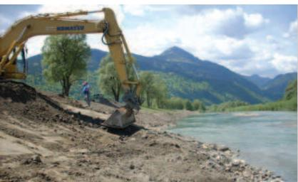
☛ In drei „Pilotstrecken“ mit einer Gesamtlänge von 1,2 km wird die Gail neu gebettet. Die Ufer werden aufgeweitet, die Dämme neu abgedichtet. Dazwischen bleibt Raum für naturnahe Flussentwicklung.
