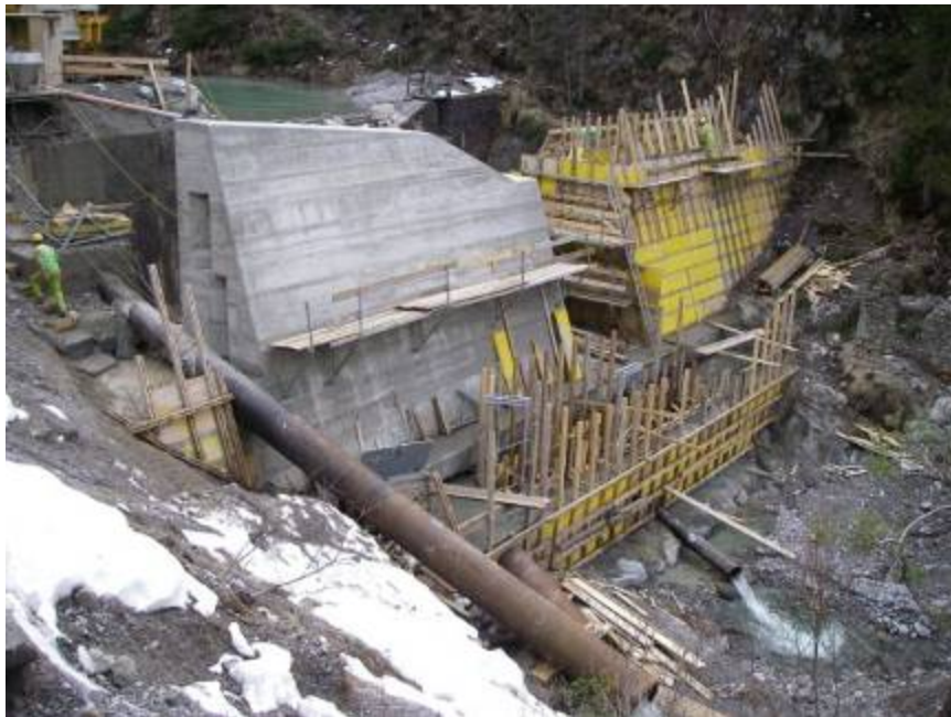
Während der Bauarbeiten (Fotos: WLW)
