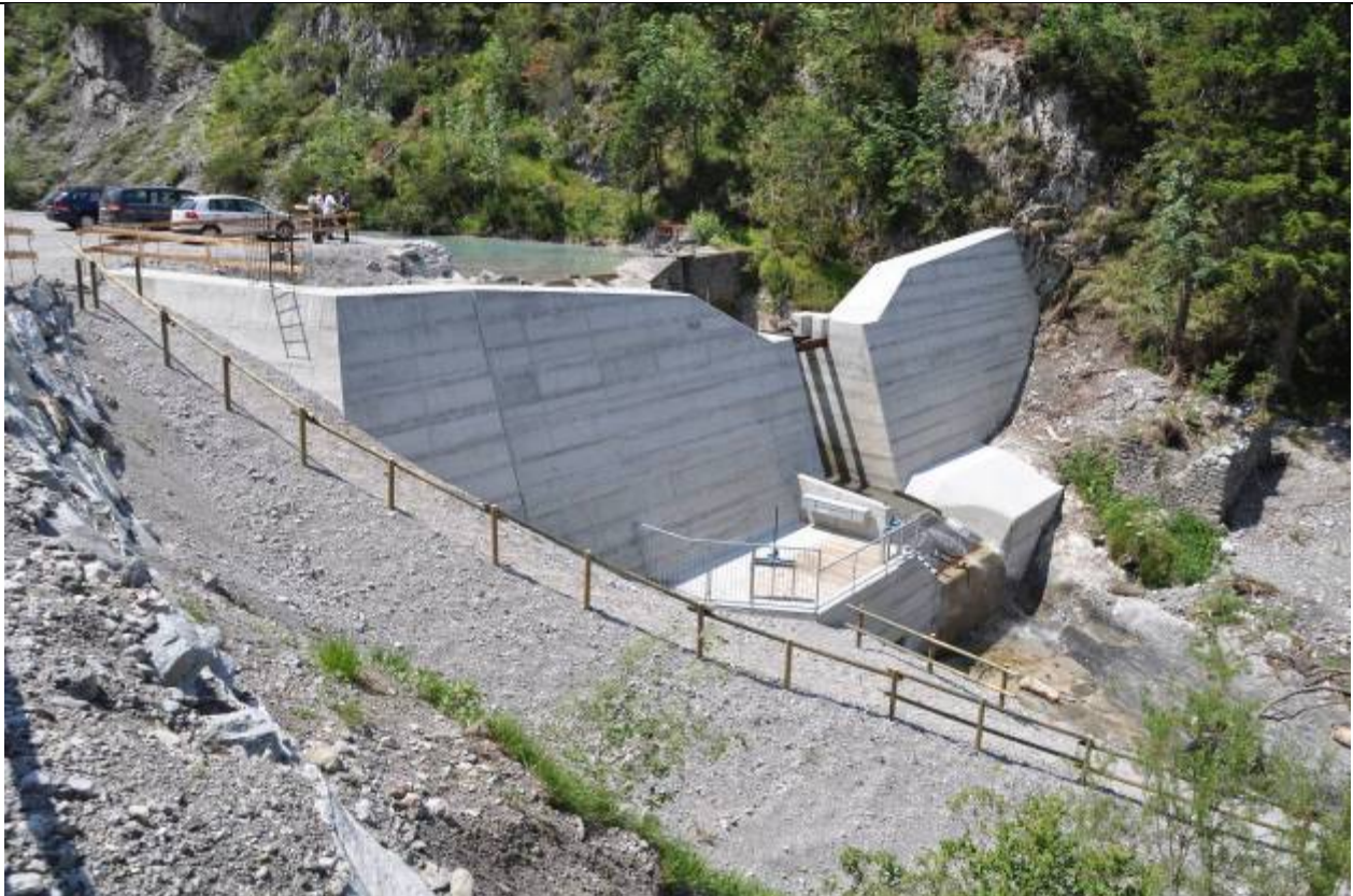
Die neue Geschiebeperr nach Baufertigstellung im Mai 2009. Knapp hinter der neuen Sperrmauer befindet sich noch die alte Sperrmauer. Sie wird in den nächsten Jahren gezielt stufenweise abgetragen. (Foto: WLV)
