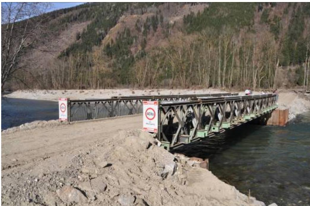
Für die Bauarbeiten am rechten Ufer (Jänner - März 2011) wurde eine Behelfsbrücke errichtet (Foto: DSC\_0011(c)Revital.jpg)
