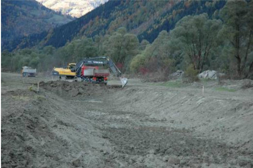
An der Flussaufweitung Obergottesfeld wird seit Feber 2010 gearbeitet. Hier der Aushub des neuen linksufrigen Seitenarmes (Oktober 2010). Die erste offizielle Flutung erfolgt am 4. Mai 2011 (Foto: DSC\_4458(c)Revital.JPG)
